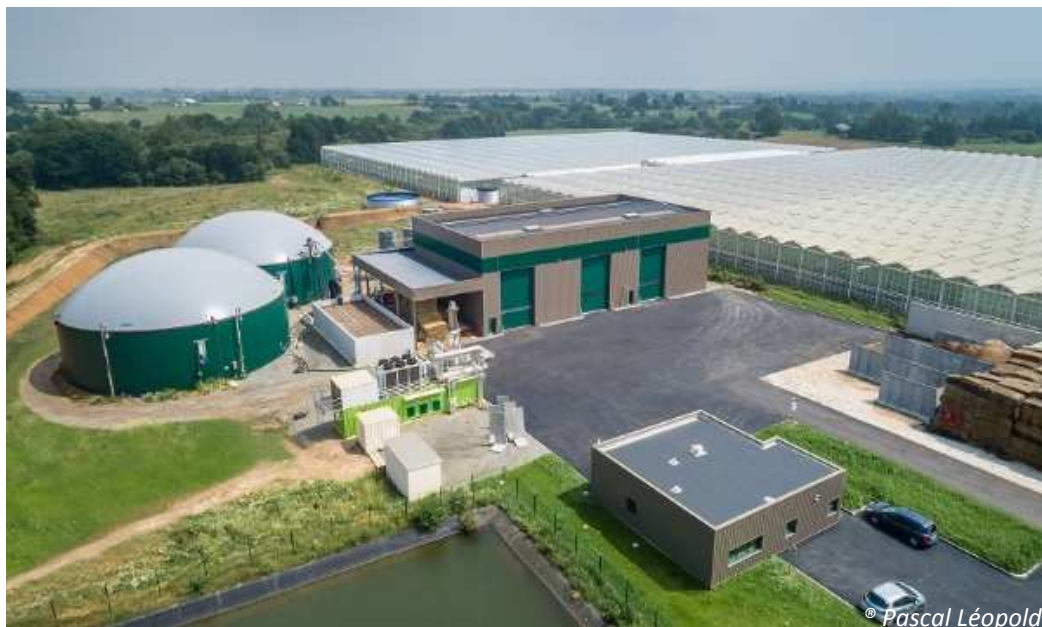
Photographie : Vue générale des éléments principaux du site – bâtiment accueil/labo, bâtiment réception, au centre : valorisation biogaz par cogénération ; à gauche : digesteurs.
